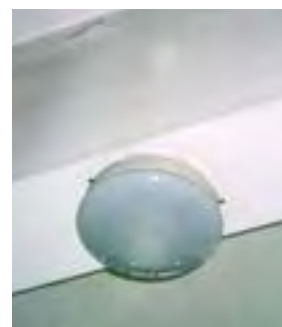
39 Een van de weinige bewaard gebleven plafonnières. Om een aanvaardbare hoeveelheid verlichting te krijgen, is het aantal armaturen veel groter geworden.
