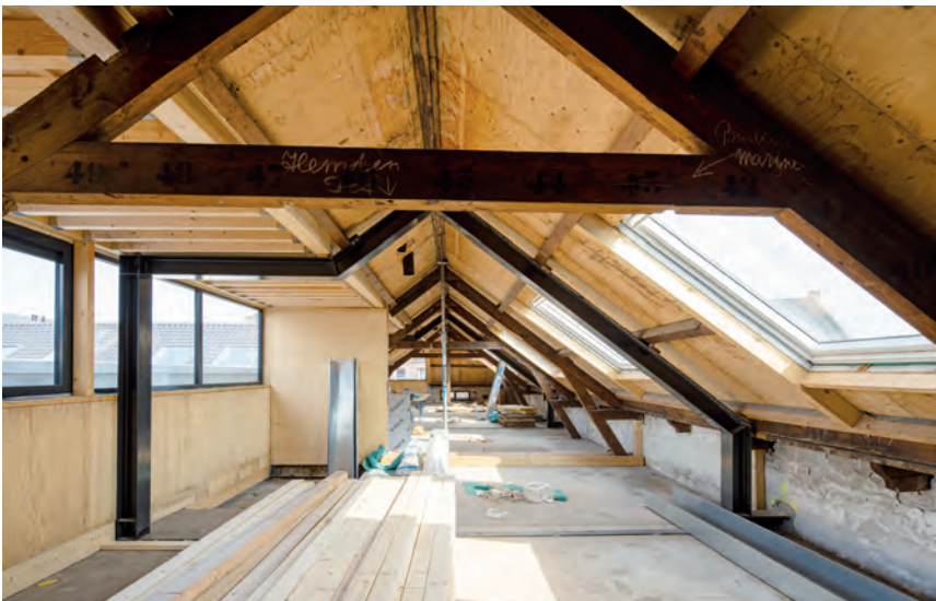
Foto links: dakopbouw op de Vrouwenvleugel. Foto rechts: door- kijk naar het Administratiegebouw, op de eerste verdieping zijn grote vensters gemaakt.
