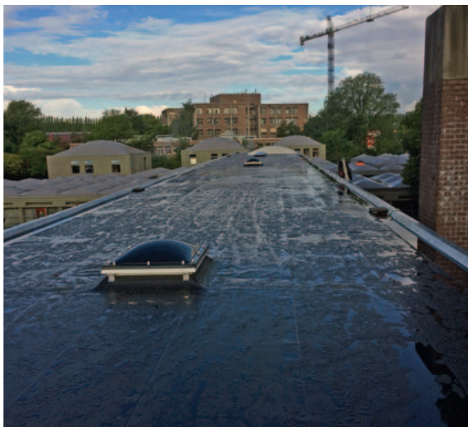
De enige zichtbare elementen van het Energiedak zijn twee kleine zwarte koepels met de installatietechnische voorzieningen.
