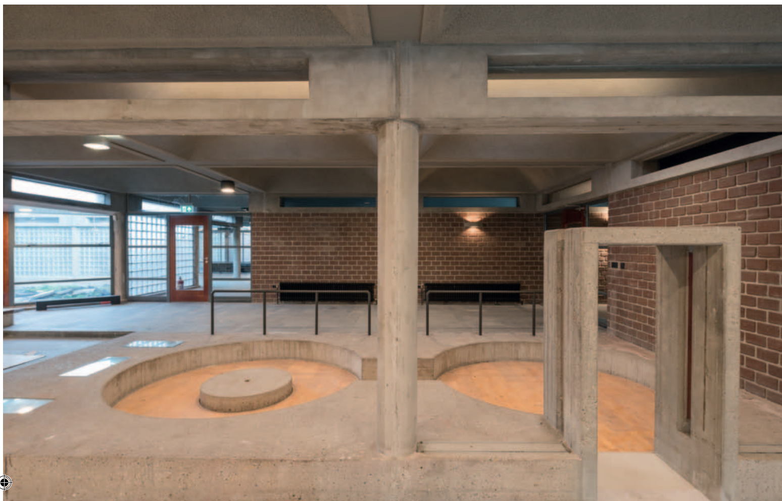
Onder de koepels is akoestisch spuitpleister aangebracht, waarbij tussen de koepels een sleuf is uitgespaard voor elektraleidingen.
